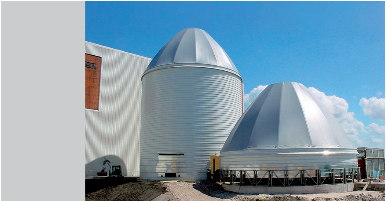
Elektrizitätswerk in Deutschland: LIPP Großsilos zur Lagerung von Holzhackschnitzel
