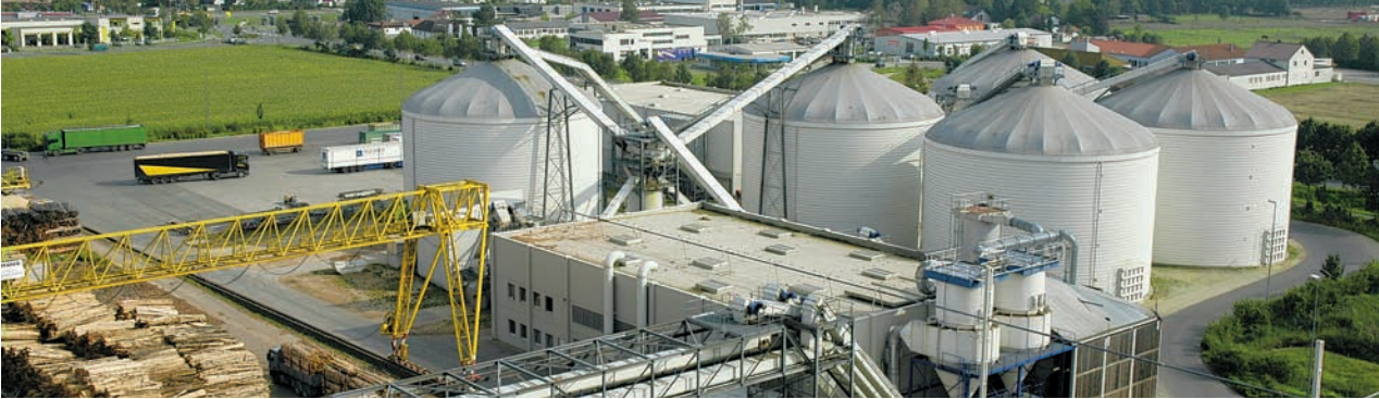
Spanplattenwerk in Deutschland: LIPP Großsilos zur Lagerung von Holzhackschnitzel
