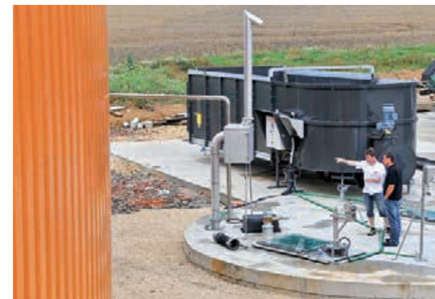
Montage des Feststoffdosierers vor Hydrolyse- und Mischbehälter
