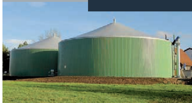
Speicherbehälter für Gärreste mit Folienabdeckung
