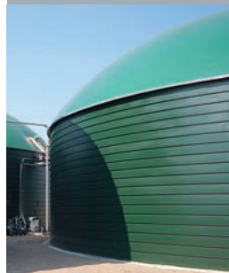
Reststofflager mit Tragluftdach
