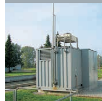
BHKW in Container-Bauweise
