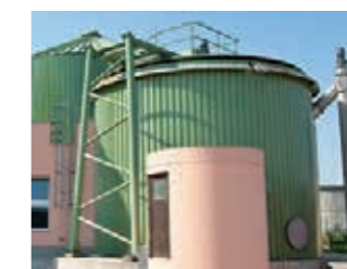
LIPP Hydrolysebehälter
