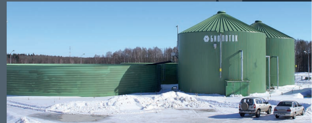
Biogasanlage in Russland, Leistung ca.: 100 kWel Gesamtinput pro Jahr: 36.755 t Rindergülle, Getreideabfälle, Maissilage
