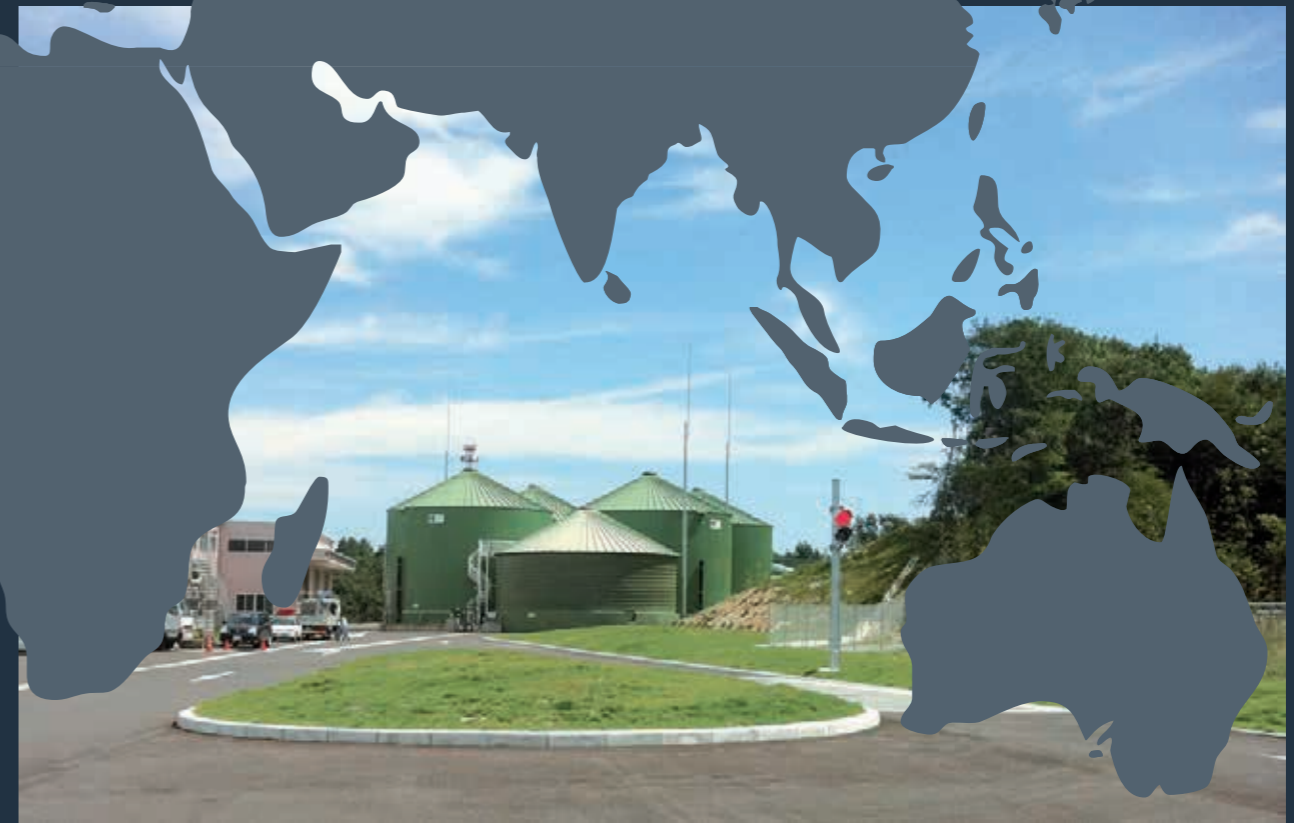
Biogasanlage in Japan, Leistung ca.: 244 kWel, 260 kWth Gesamtinput pro Jahr: 58.400 t Lebensmittelabfall, organischer Schlamm
