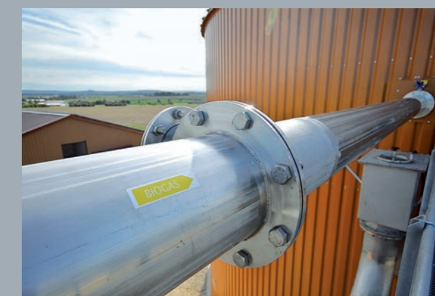
Biogas-Pendelleitung
