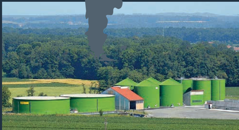
Biogasanlage in Österreich, Leistung ca.: 1 MWel Gesamtinput pro Jahr: 21.900 t Gülle, Glycerin, Silomais, Körnermais
