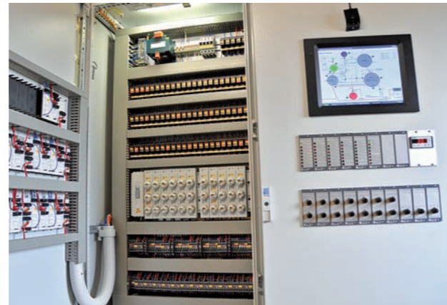
Kontrolle durch Mess-, Steuer- und Regelungstechnik (MSR)
