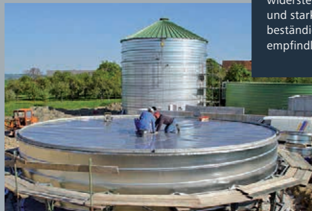
Montage Edelstahl-Membranabdeckung
