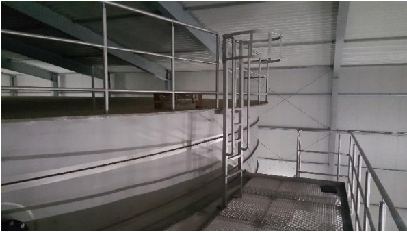
Abb.30 Aufstieg zum Membrandach
