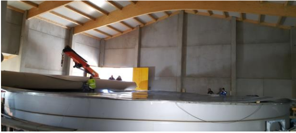
Abb.8 Montage Membrandach
