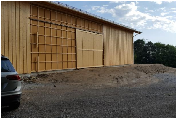
Abb.22 Montageöffnung mit Schiebetor
