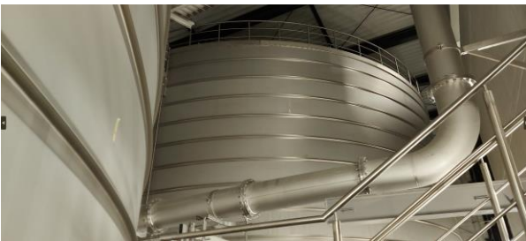
Abb.26 Behälter komplett montiert
