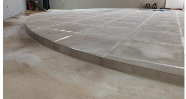
Abb.5 eingebrachter Estrich
