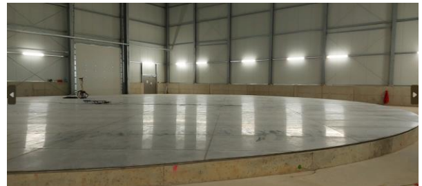
Abb.6 Boden glatt eingeschweißt
