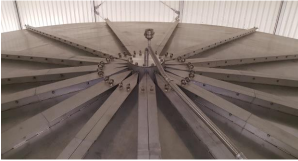
Abb.17 Kegeldach mit Sparren
