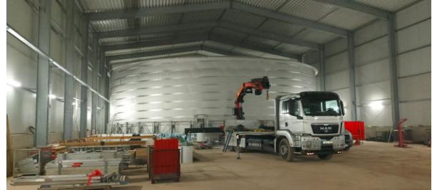
Abb.28 Großbehälter im Bau
