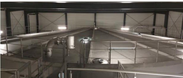
Abb.27 Kegeldach mit Dachgeländer
