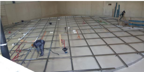
Abb.4 Bau der Unterkonstruktion
