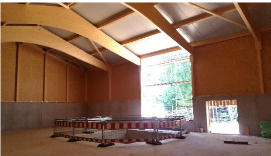
Abb.3 Halle mit Montageöffnung
