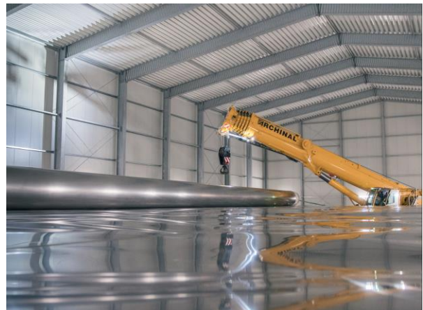
Abb.29 Auflegen des Membrandachs
