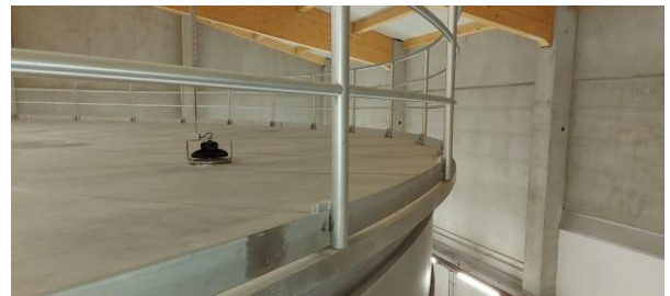
Abb.21 Membrandach mit Geländer
