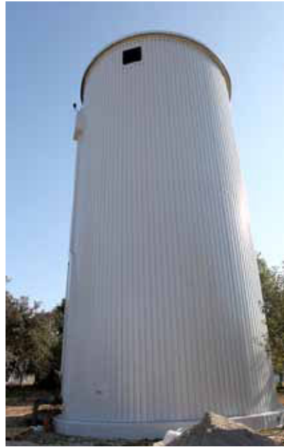
Der neue Behälter, der 800 m 3 fasst, hat einen Durchmesser von 8 Metern und eine Füllhöhe von 14 Metern. Er wurde von der Firma Lipp vor Ort mit einem neuartigen Schweißverfahren erstellt.
