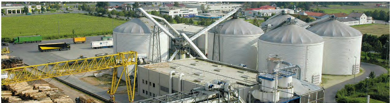
Spanplattenwerk in Deutschland: LIPP Großsilos zur Lagerung von Holzhackchnitzel
