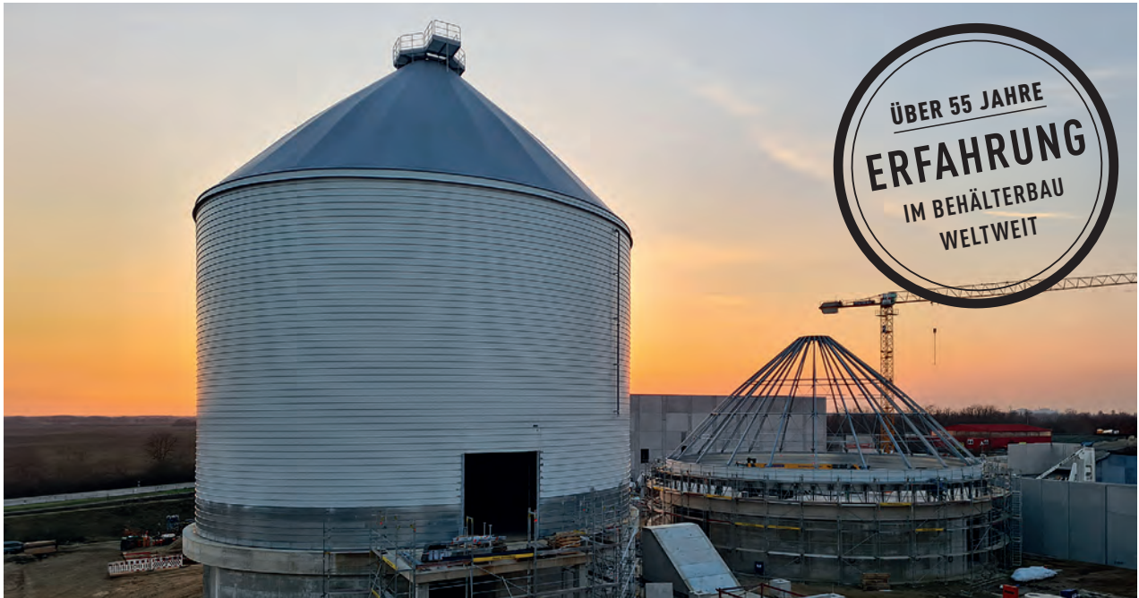
Holzfasерplattenwerk in Deutschland: LIPP Großsilos zur Lagerung von Holzhackschnitzel mit je 15.000 m 3
