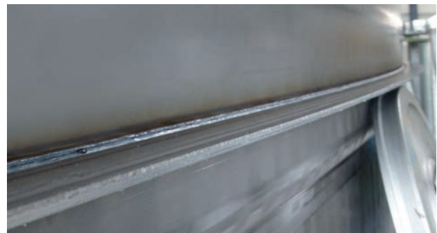
LIPP Stahlbehälter mit speziellem, umlaufenden Profil
