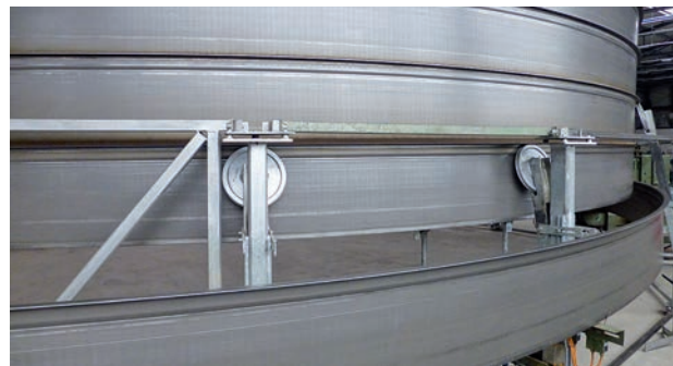
Außenansicht, LIPP Stahlbehälter bei Fertigung
