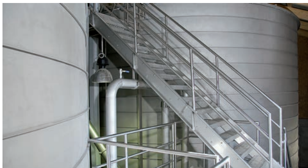
LIPP Edelstahlbehälter als Trinkwasserbehälter, geschweißt
