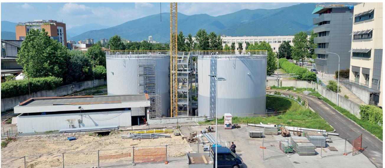
Bild 4. Mit der Lipp-Schweißtechnik wurden am Kraftwerksstandort Centrale Nord zwei Pufferspeicher errichtet
