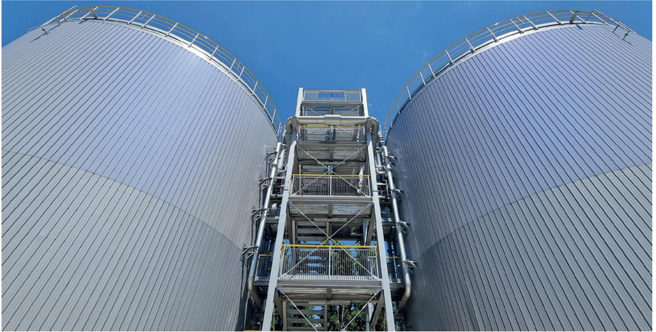
Zwei Pufferspeicher mit einem Nutzvolumen von jeweils 2 200 m<sup>3</sup> sind am Kraftwerksstandort Centrale Nord im italienischen Brescia entstanden
