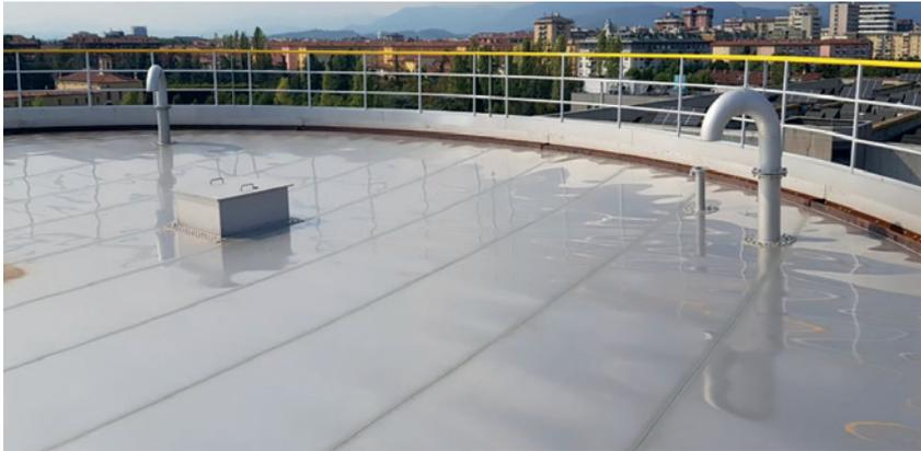
Bild 3. Die Edelstahlmembranabdeckung ist eine freitragende, leichte Konstruktion mit hoher mechanischer Festigkeit, die Schneelasten und starkem Wind widersteht. Sie wird im Werk vorgefertigt, zur Baustelle transportiert und vor Ort installiert
